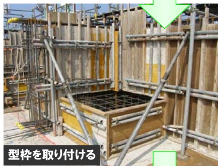
鉄筋を組み立てる
