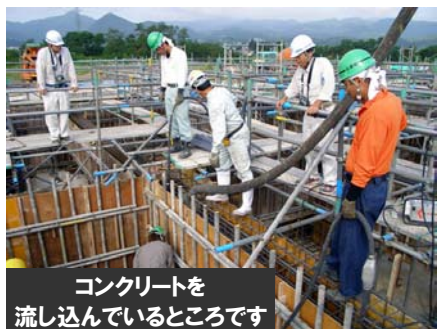
ポンプ車を使い、コンクリートを流し込んでいます
