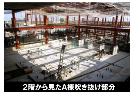
内部の、これから屋根工事が行われる部分
