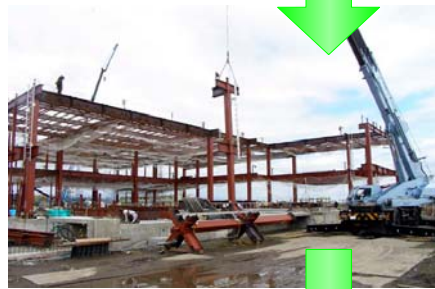
南側に向かって進んでいます
