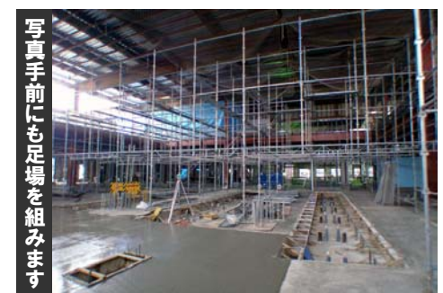
二階吹き抜け部から見下ろす
