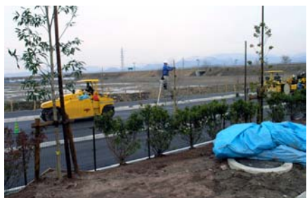
植栽工事。雪もなく順調でした
