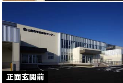
全景(西北から)
